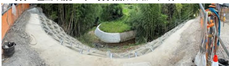
写真-3 盛土法面側パノラマ写真-撮影日:令和7年7月11日
