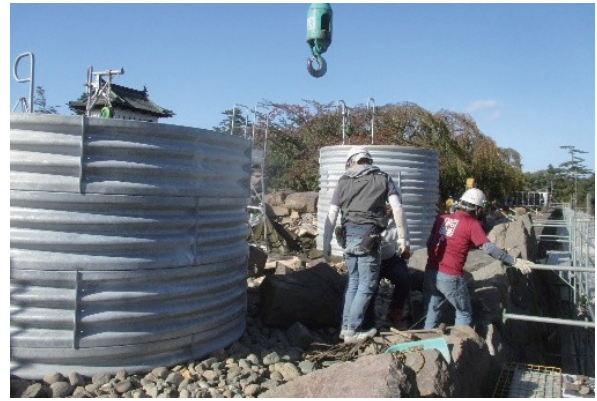
写真4 天守が移動した後の天守台に杭基礎を施工
