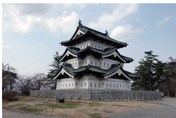
写真3 曳家して一時的に別の場所に移動した弘前城天守
