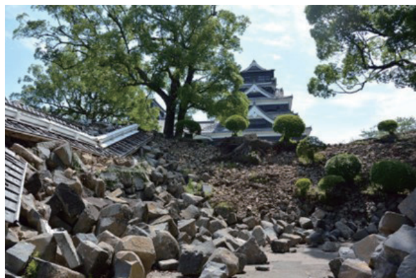
写真-2 熊本城石垣の倒壊
