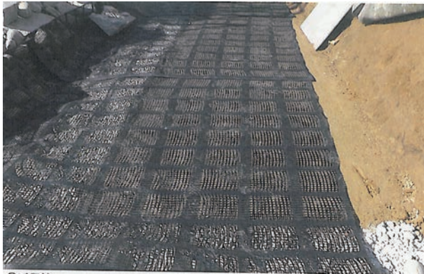
写真-3 石垣背面に敷設された補強のためのジオグリッド
