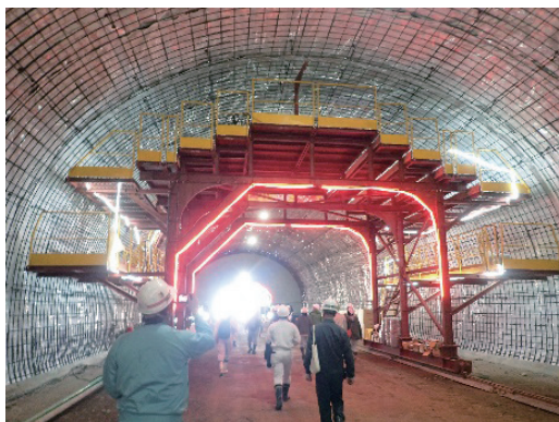
佐野トンネル内部
