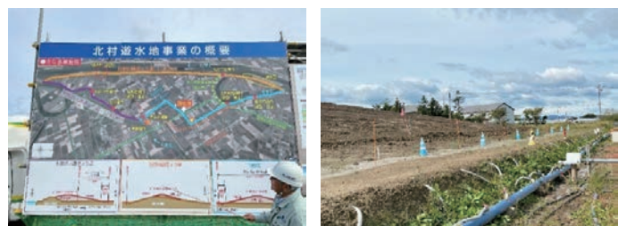
北村遊水地の概要とドレーンによる排水状況
