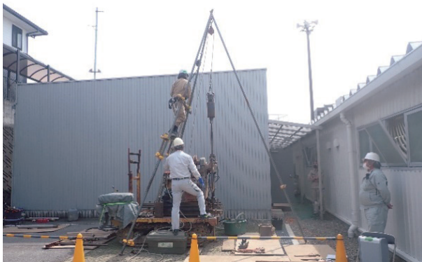
ボーリング作業見学
