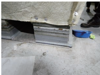
鉄板による沈下調整
