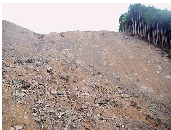
Fig.2 崩壊斜面下部に溜まった土砂
