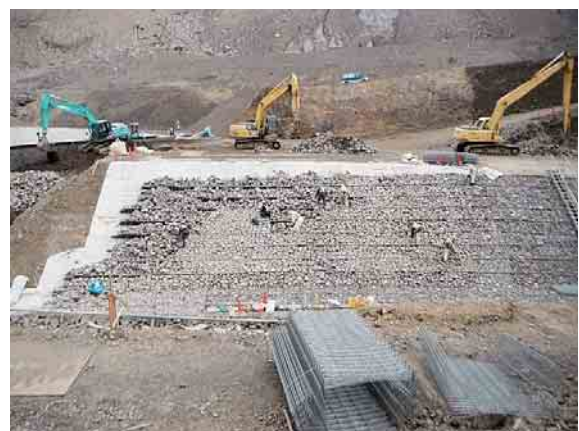
Fig.1 床固工 (赤谷地区)
