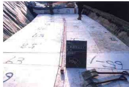
写真-1 EPS組み立て状況
