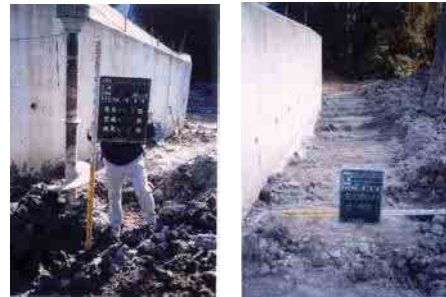
写真-2 深層混合処理工法
