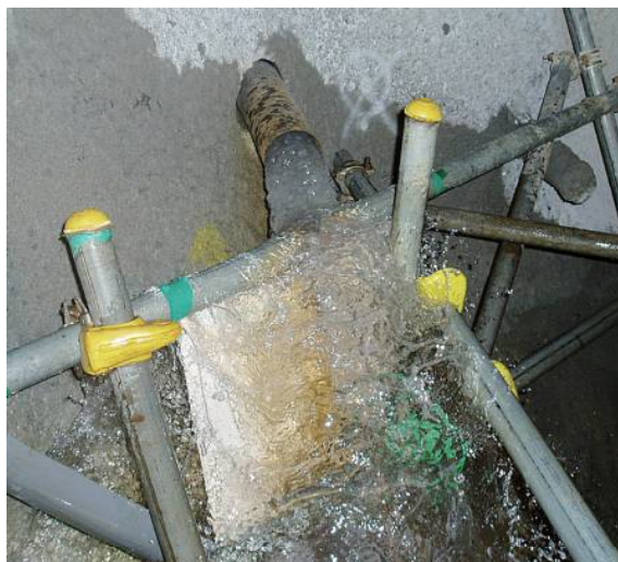
切羽からの湧水の状況
