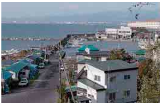
現在の船入潤防波堤 (平成14年10月 長嶺撮影)
