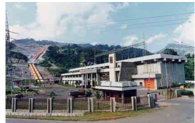
写真－３ 発電所と鉄管路
