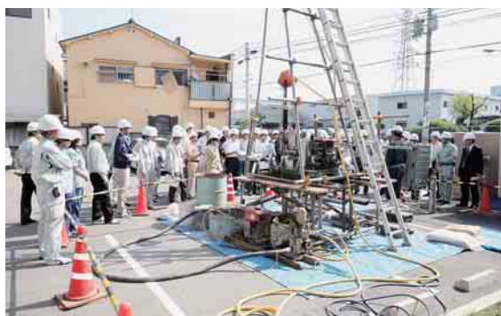
ボーリング調査研修
