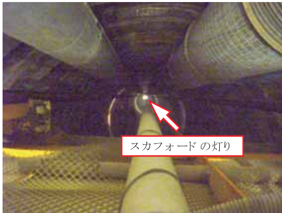
坑道内足場から見下ろした縦坑内の様子 (スカフォードの灯りが見える)
