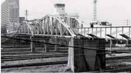
写真1: 旧小久保跨線橋
