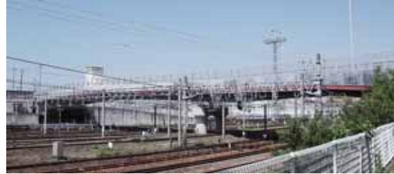
写真2: 現西明石陸橋
