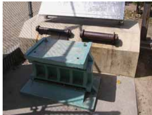
写真4: そのピンと橋梁の支承
