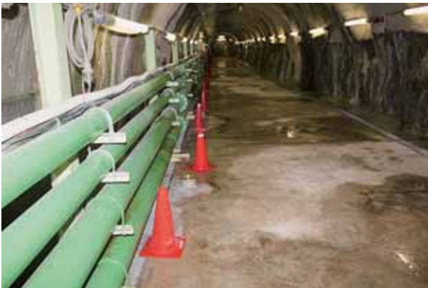
写真-1: センサー群 埋設コーン下(に)
