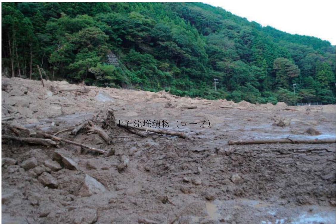
第8図 富田川に流入した土石流と地すべりダム（上：上流側，下：下流側からの撮影）
