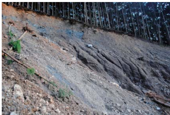
第10図 崩壊部：剪断変形の著しい泥岩層（左）と厚い風化帯（右）
