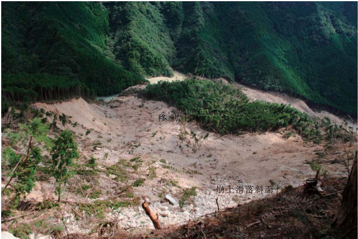
第17図 崩土滑落斜面，移動土塊及び地すべりダム。
