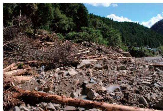
第14図 第1堰堤（左岸）にみられる土石流堆積物
