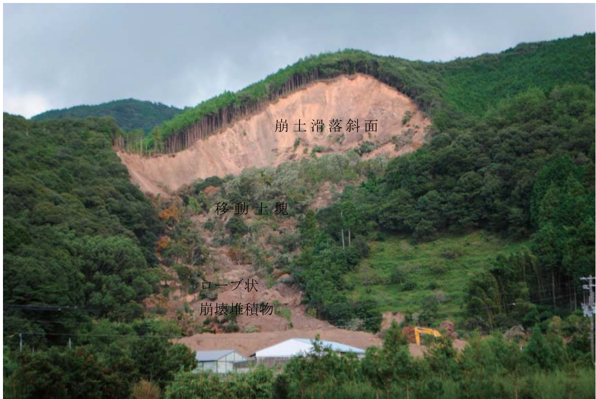
第2図 伏菟野の大規模崩壊の全景
