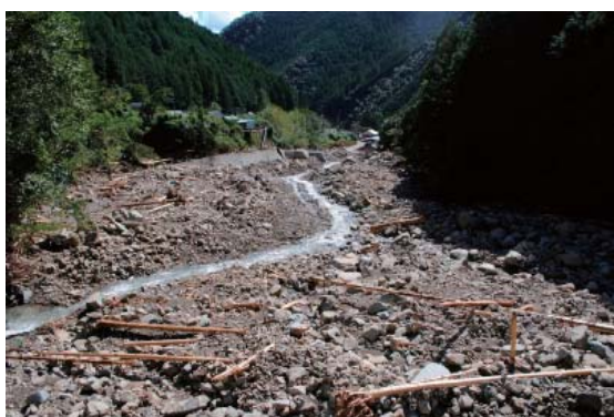
第13図 深谷集落上流域の土石流堆積物（流路は復旧工事によって改変）
