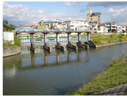
写真 - 4 合流部の水門の全景
