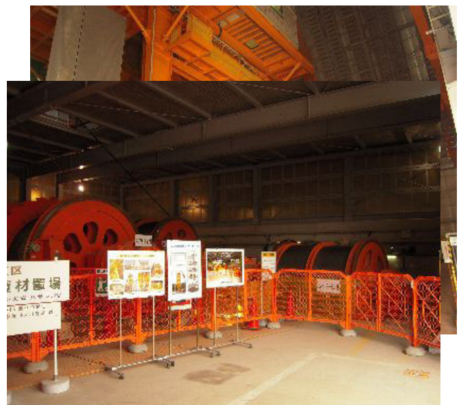
写真-3: 巻上機_全景
