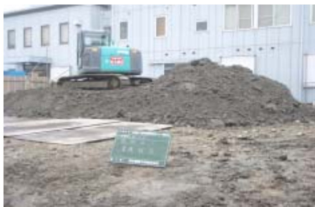
写真-3 固化処理後の排土
