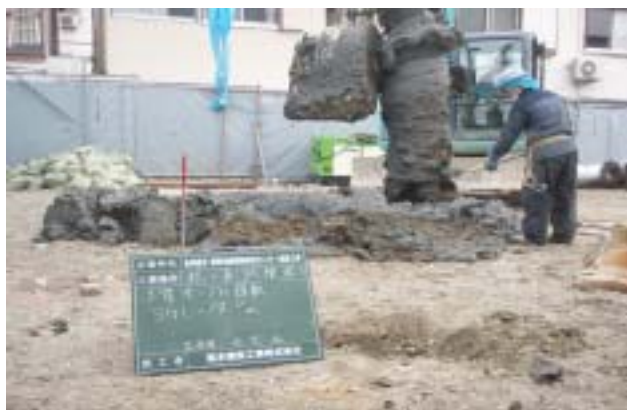
写真-1 GL-14m 付近の排土
