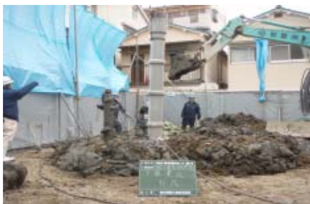
写真-2 排土全体の様子
