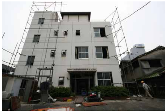
写真-2 解体の準備始まる
