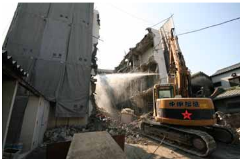
写真-3 解体が進む
