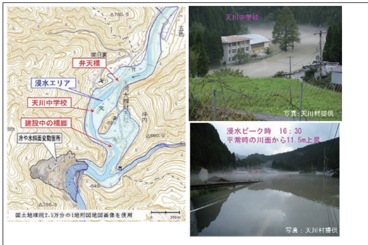
図 4.5 川の堰き止めによる浸水状況
