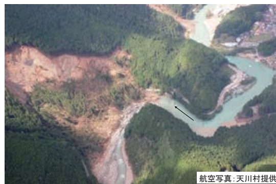
写真 4.9 滑動土塊による川の堰止め
