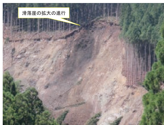
写真 4.3 滑落崖の崩壊
