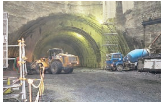
巨大なトンネル断面
