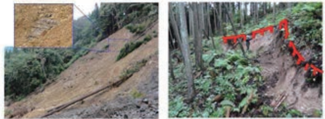
A-1ブロック下方の状況。露
