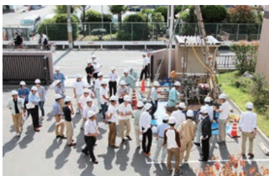
ボーリング調査現場講習
