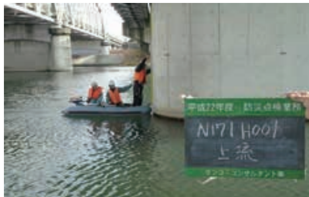
写真-2 ボート利用による点検
