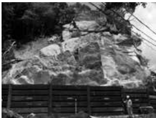
写真-1 調査地現況（平成 20 年 7 月）
