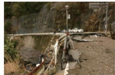
写真 2 路面陥没と GPS 観測状況
